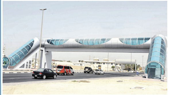
جسر للمشاه لتسهيل قطع الطريق
